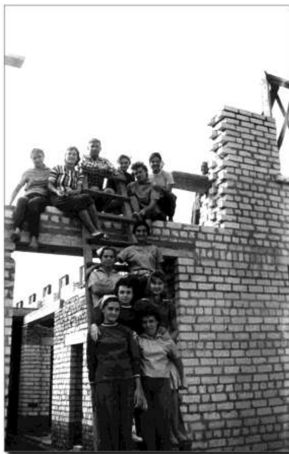
38. 1-а група математиків на будівництві гуртожитку (випуск 1966 р.).
