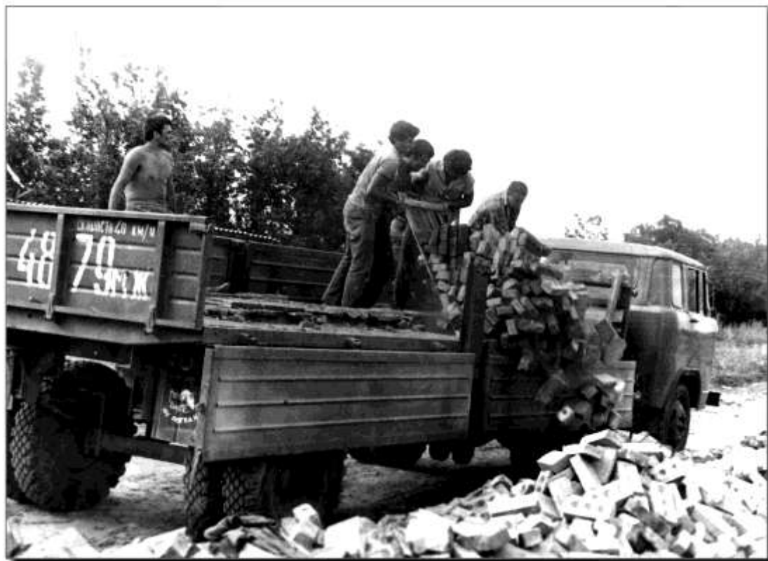
61. Студенти на будівництві. 1973 р.
