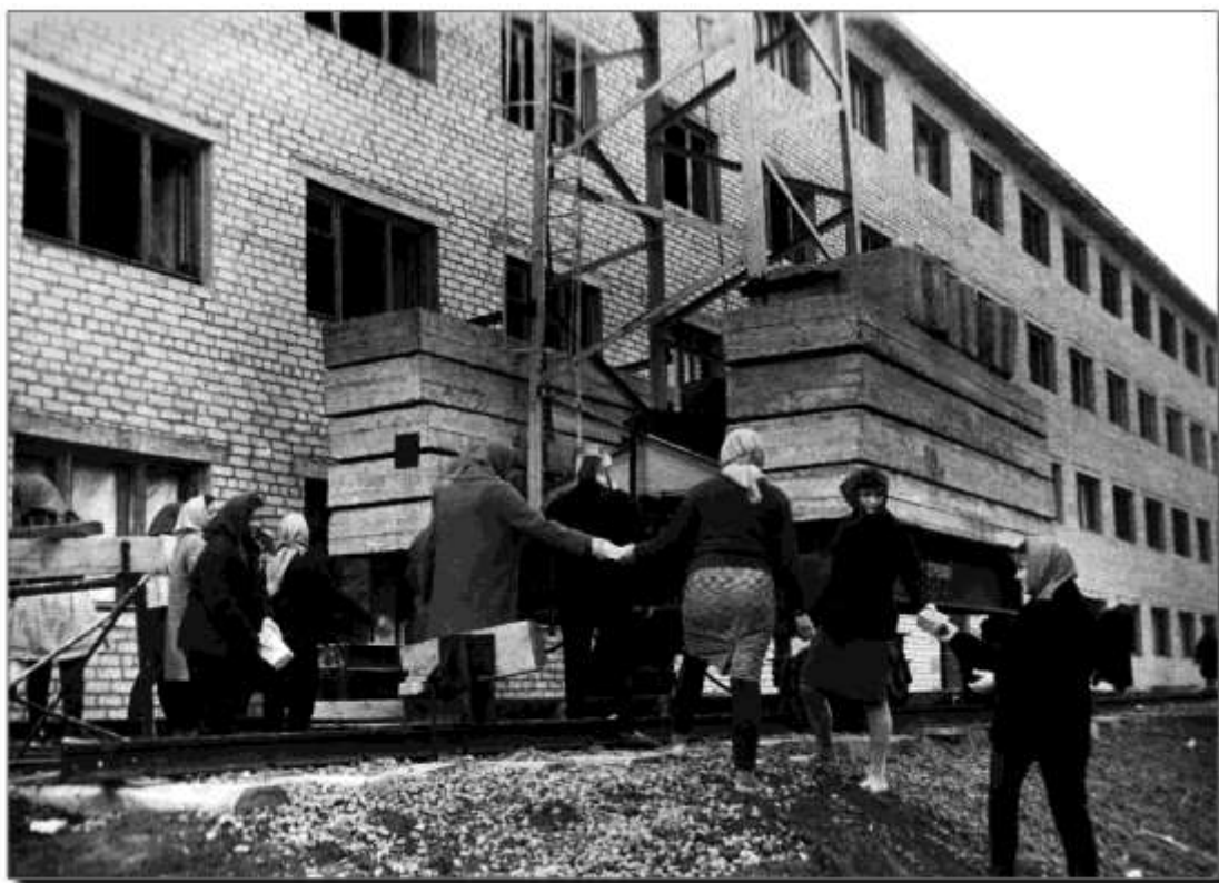
9. Будівництво студентського гуртожитку.
