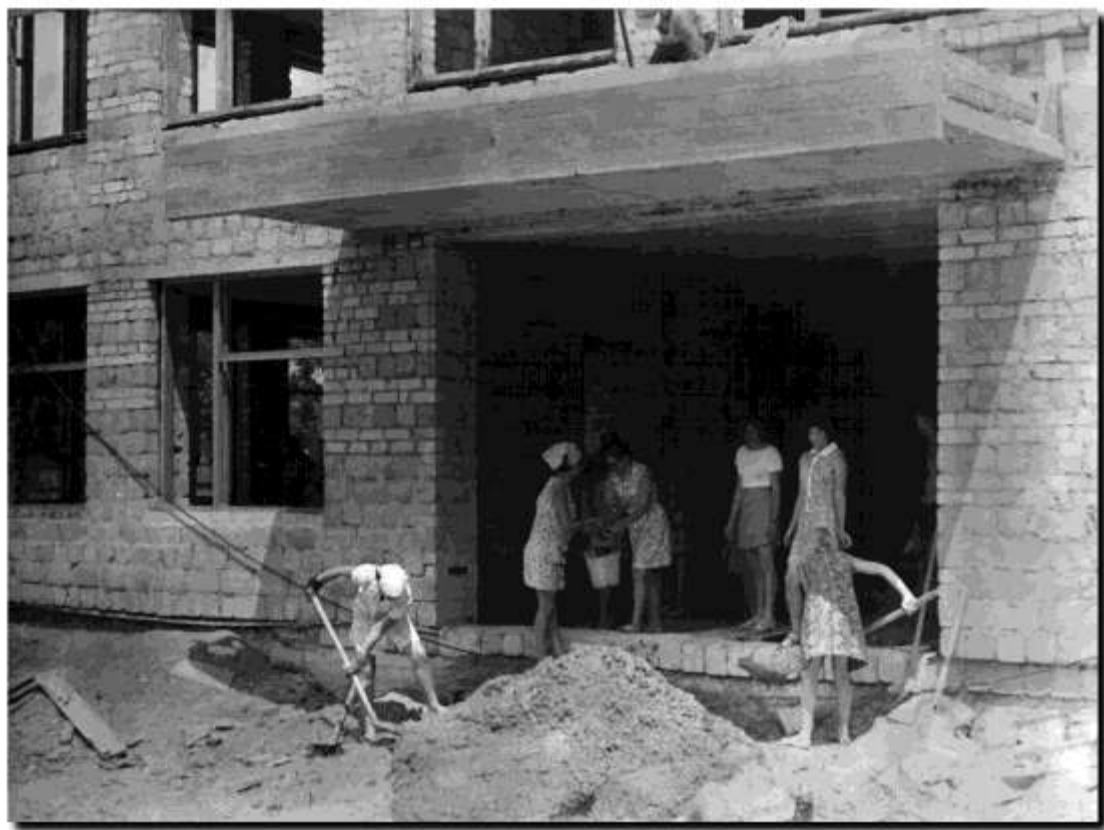
60. Будівництво інститутського корпусу. Літо 1973 р.
